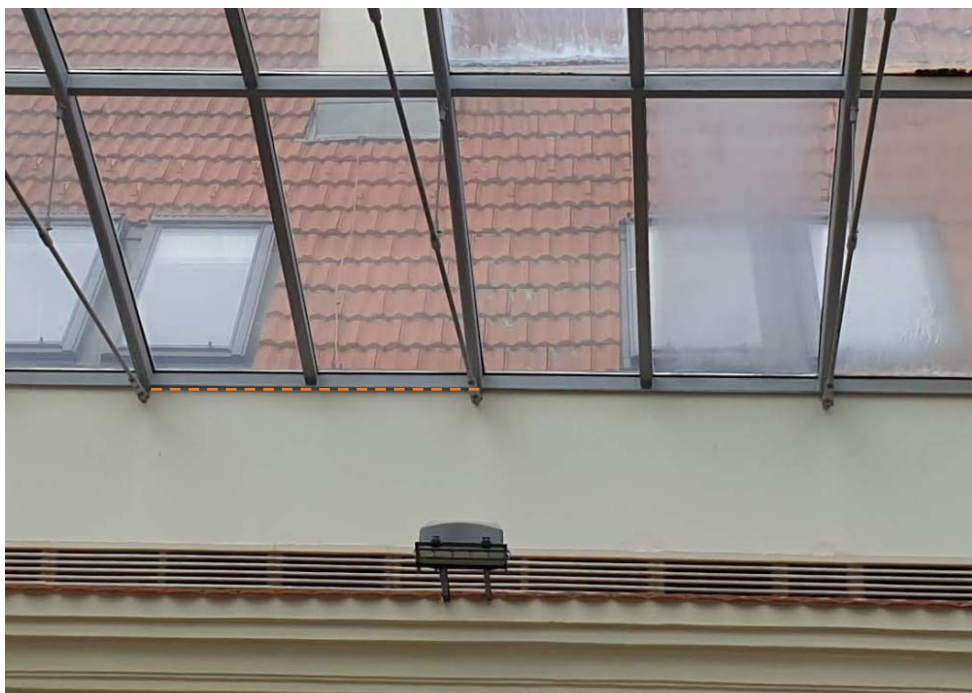
Obrázek 2 - uchycení konstrukce na atikách
